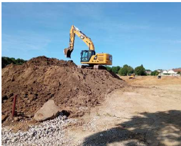
Photo 17 : zone de travaux. ©Rainette, 2022
