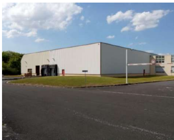
Photo 13 : Bâtiments industriels. ©Rainette, 2022
