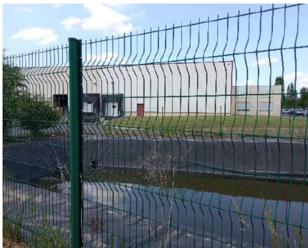
Photo 11 : Bassin de rétention. ©Rainette, 2022
