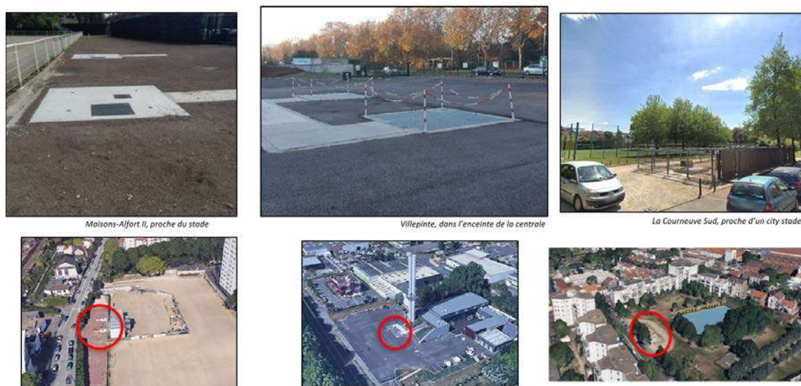
Figure 1 : Exemple de photographies de têtes de puits, à proximité d'équipements publics, prises sur des sites géothermiques en exploitation en région parisienne.
