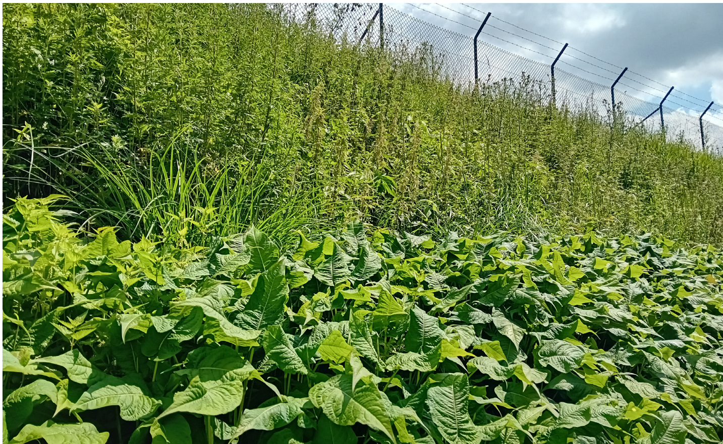
Il y a deux types de végétation distincts sur le talus (source TRANS-FAIRE, 2024)
