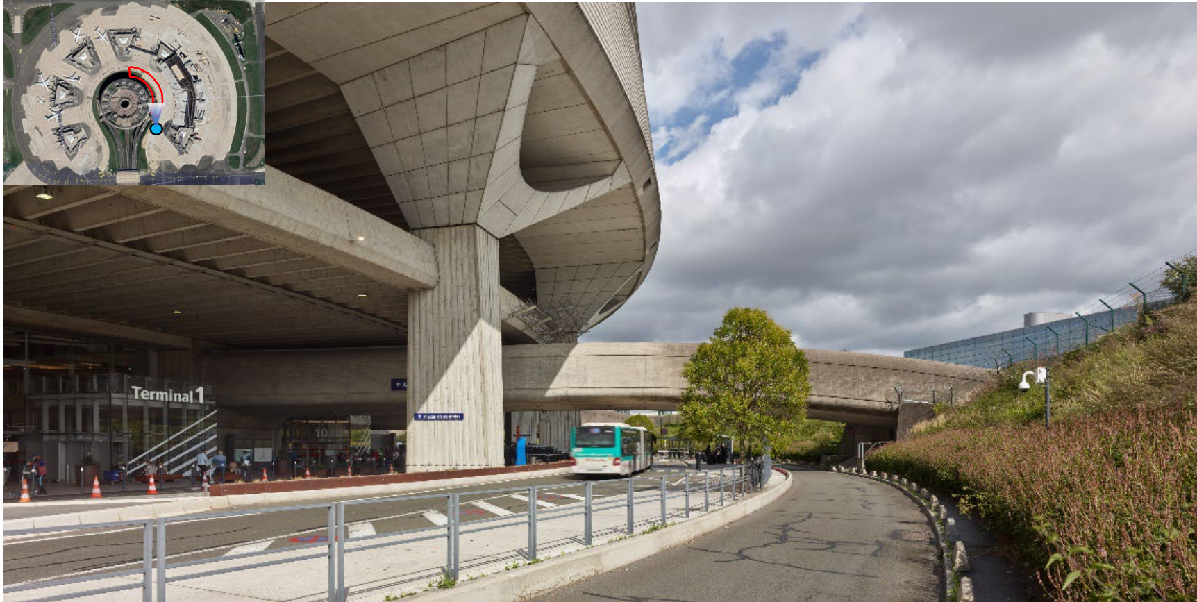
Photo du Terminal 1 : Corps central, Linéaire routier et talus (4 septembre 2023)
