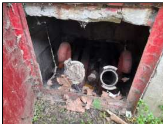
Tubes de remplissage FOD
