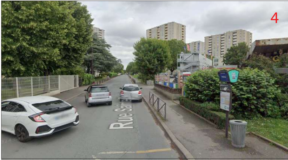
Angle Sud-ouest du site Vue depuis la rue Sainte-Colombe vers le Nord
