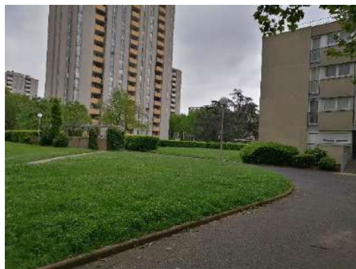
Photo 1 - Bâtiments, voirie et autres cheminements omniprésents sur le site (Photo Alisea/B.Marandon)
