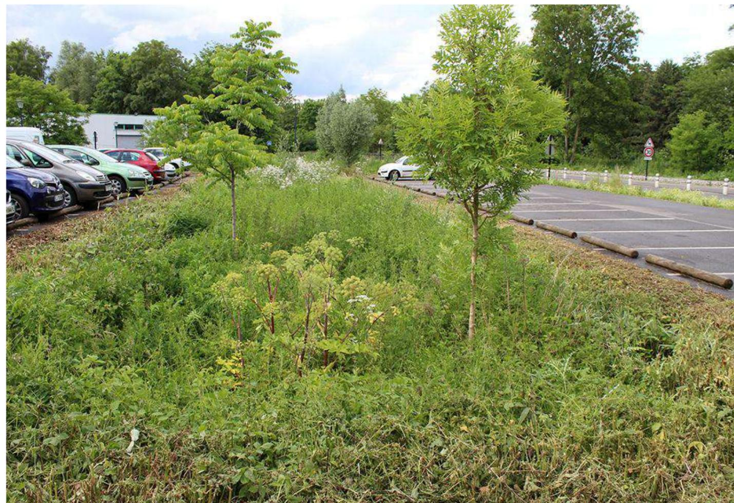
La gestion des eaux pluviales sera exclusivement alternative. Les eaux du bâtiment et des aménagements extérieurs ruisselleront et s'infiltreront dans les noues plantées du parking.
