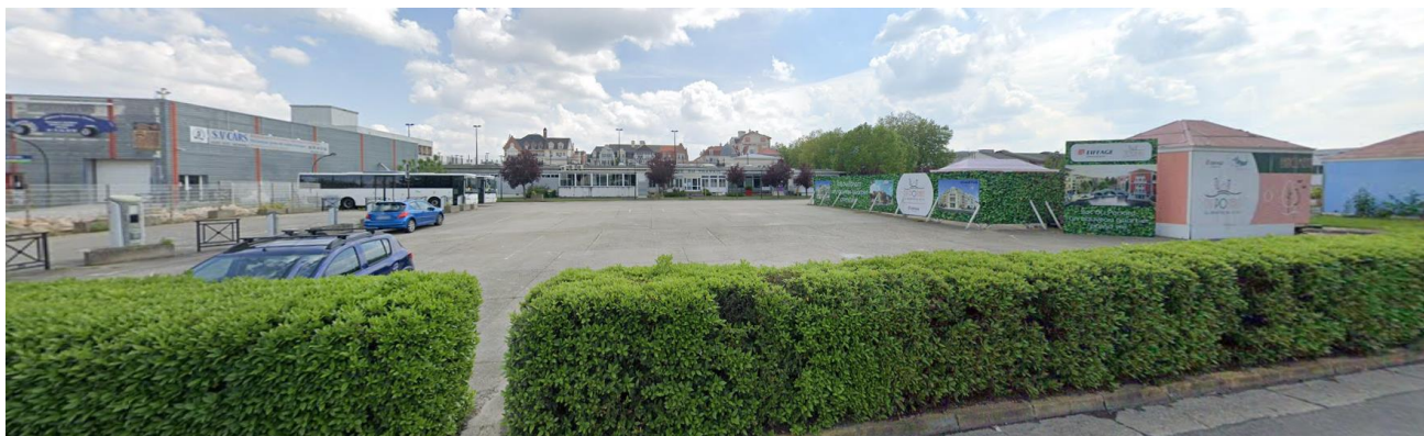
Site de projet après enfouissement des lignes (source : google street view mai 2024)
