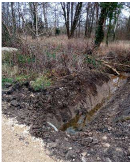
Figure 36 : Illustration d'un point de sortie des eaux du fossé périphérique vers la zone humide (source : PCM EEE, hiver 2024)
