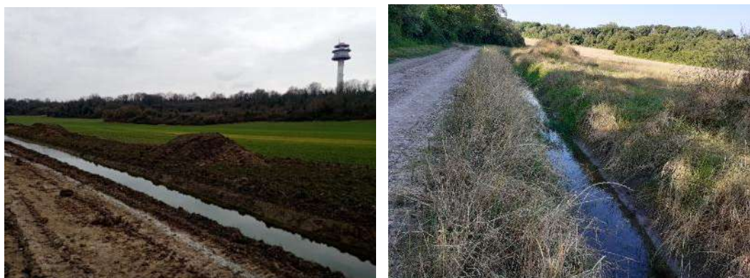
Figure 35 : Illustrations du fossé périphérique le long du chemin des Bouts Cornus (source : PCM EEE, janvier 2024)
