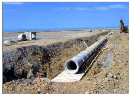
*Figure 23 - Illustration tuyau en béton.*
