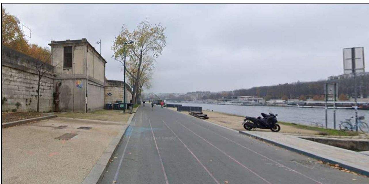
PHOTOGRAPHIE 4 : VUE SUR LES QUAIS OÙ LES OUVRAGES DE PRISE ET DE REJET EN SEINE SONT PROJETÉS (1/2) (SOURCE : GOOGLE STREET VIEW, DÉCEMBRE 2022)
