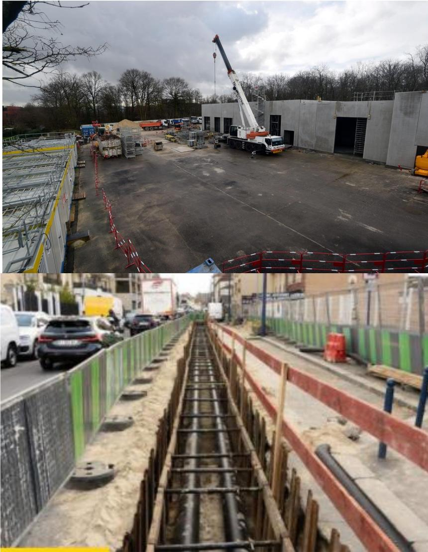
Figure 16 : Exemple d'un chantier de construction (gros œuvre) d'une centrale géothermique et réalisation d'un réseau de chaleur enterré
