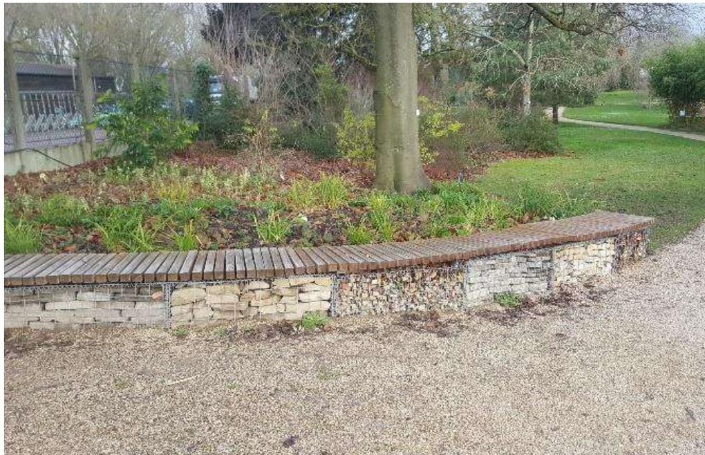
Figure 11. Exemple d'un gabion avec assise (Ecosphère)
