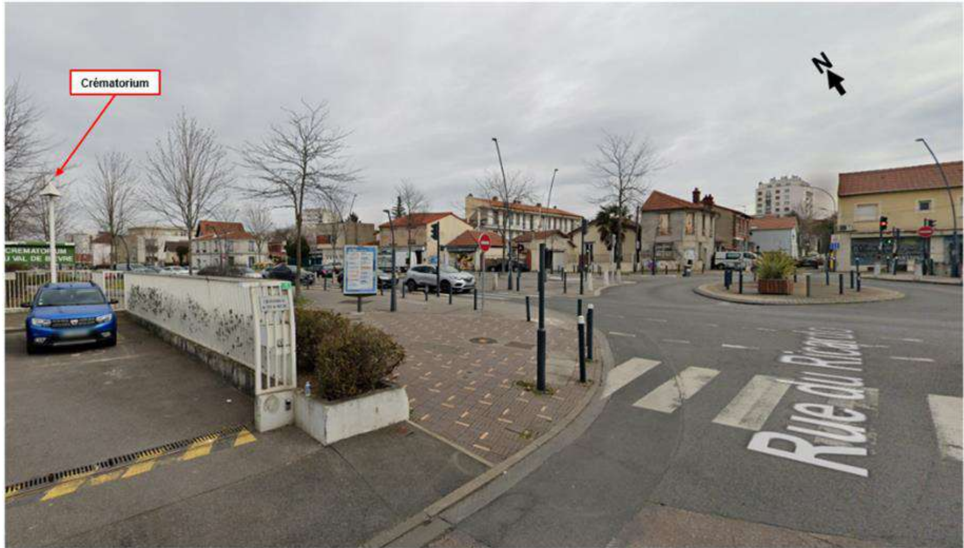
Vue depuis le Sud du crématorium (rue du Ricardo) vers le Nord-Est et l'Est Source : Google Maps
