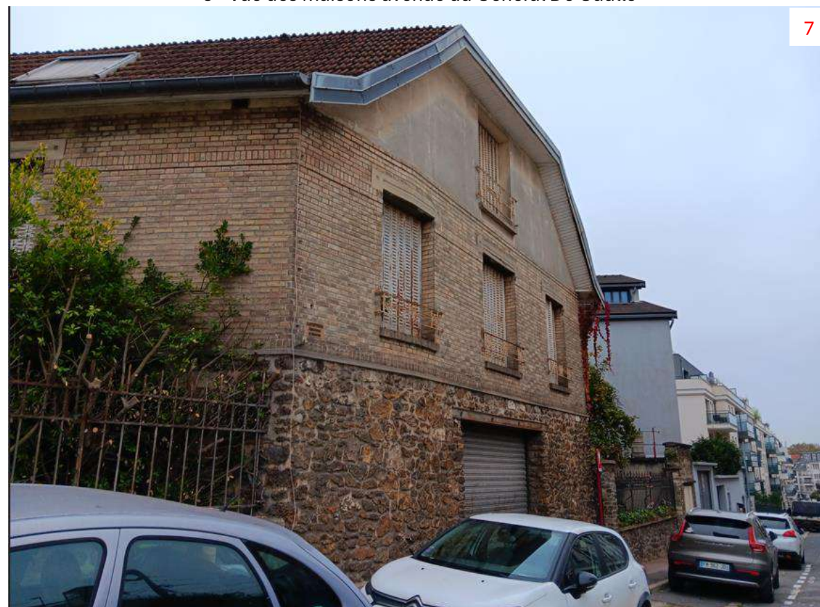
7 - Vue des maisons rue du Clos Montholon
