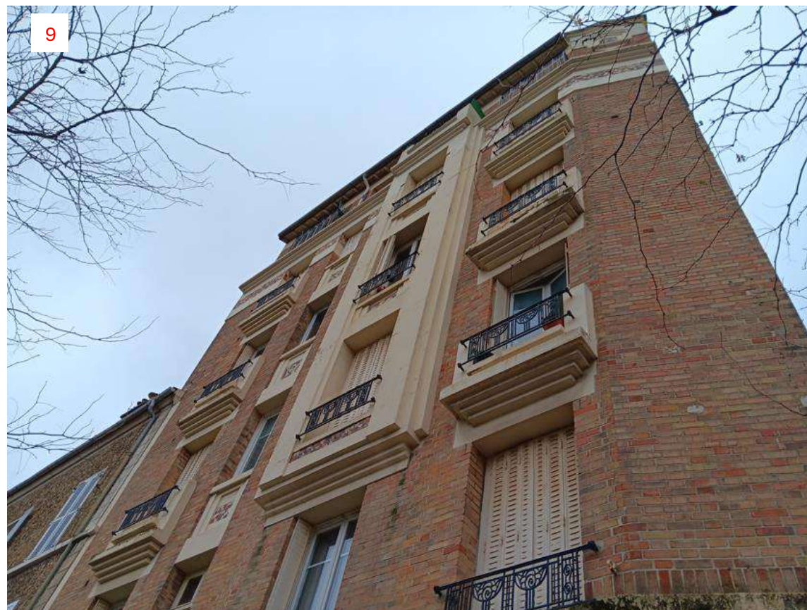
9 - Vue des maisons avenue du Général De Gaulle
