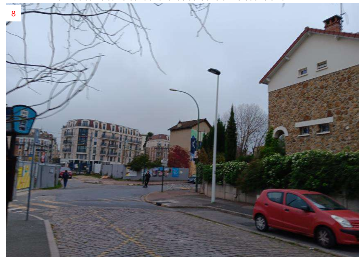
8 - Vue sur le carrefour avenue du Général De Gaulle et rue Clos Montholon
