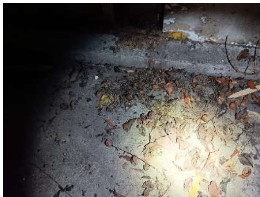
Figure 15 : Traces d'alimentation sur des noix (Systra, 2024)
