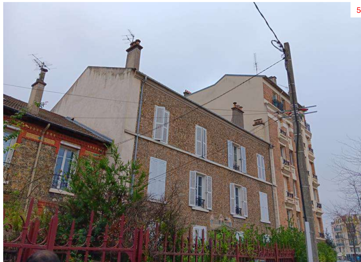
5 - Vue des maisons avenue du Général De Gaulle
