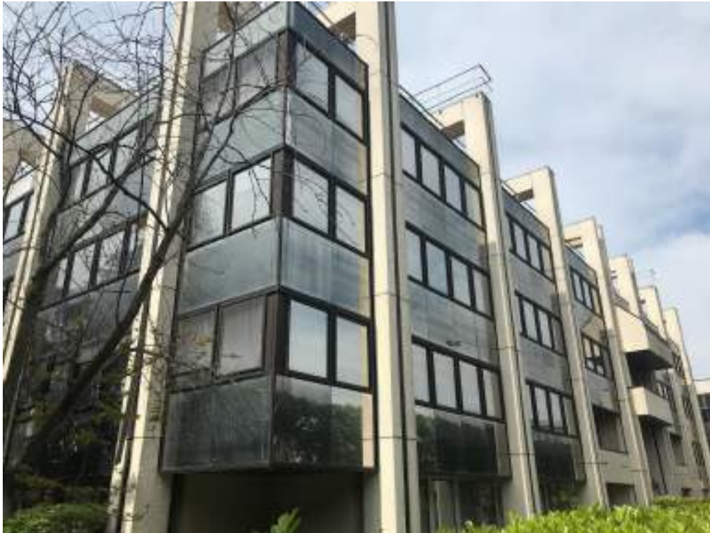
Photographie 9 : Vue sur le bâtiment de bureaux situés au sein du site d'étude depuis l'avenue Victor Hugo
