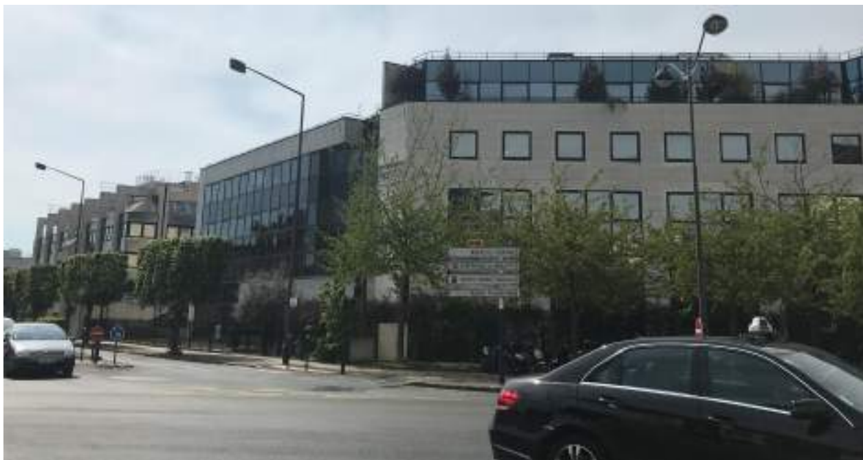
Photographie 3 : Vue depuis le nord-est du site du projet
