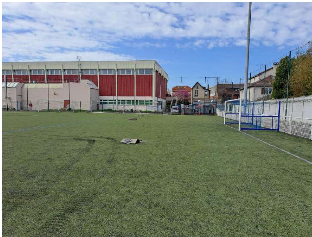
Terrain de sport et gymnase au droit du site
