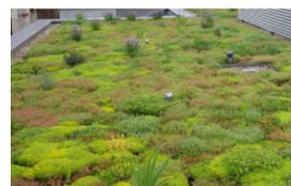
Une gestion de l'eau intégrée, en permettant l'infiltration et en utilisant la 5<sup>ème</sup> façade
