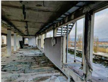
photo 10 - poteaux + toiture démolis niveau 5 attique
