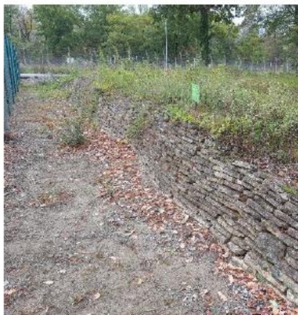
Muret de pierres sèches conçu pour les lézards
