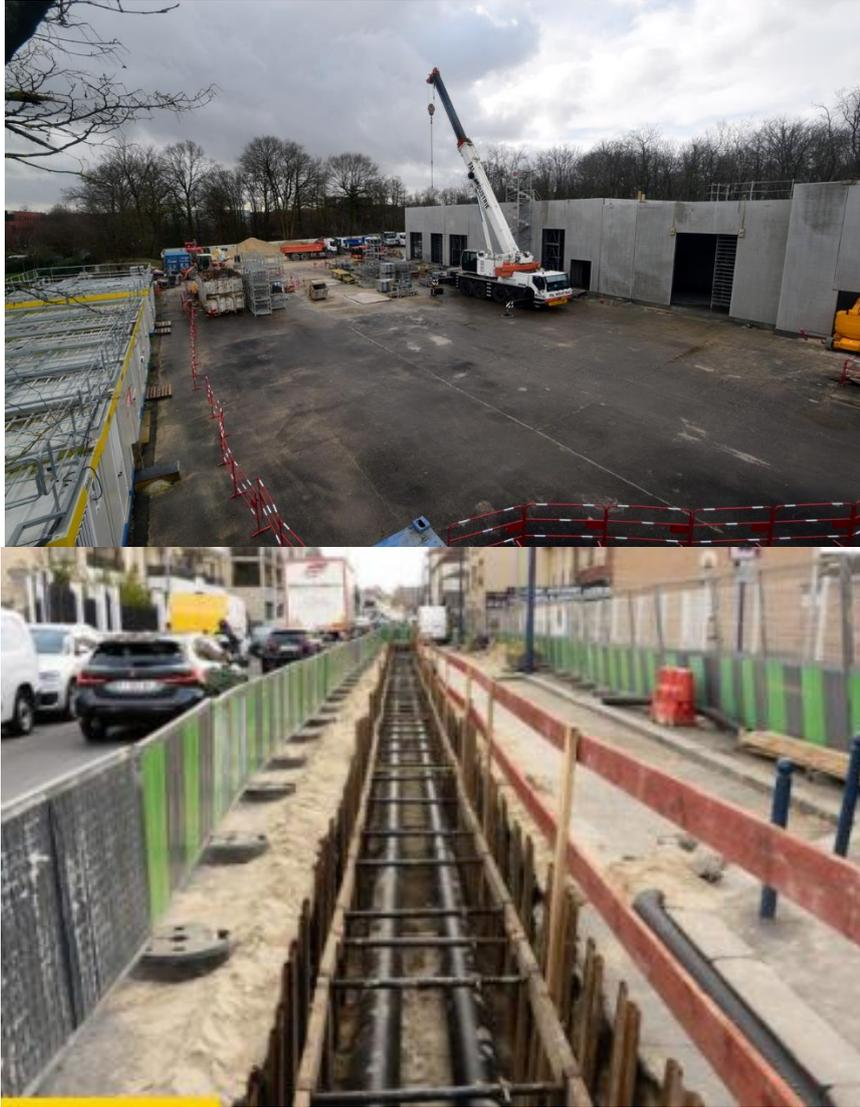
**Figure 21 : Exemple d'un chantier de construction (gros œuvre) d'une centrale géothermique et réalisation d'un réseau de chaleur enterré**
