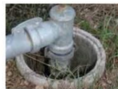
>> 2 hérissons sont morts dans ce système d'irrigation.
