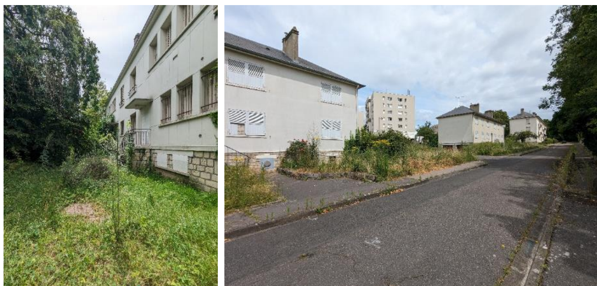
Figure 5 : Photographies des bâtiments existants sur les parcelles 0272 (à droite) et 0274 (à gauche)
