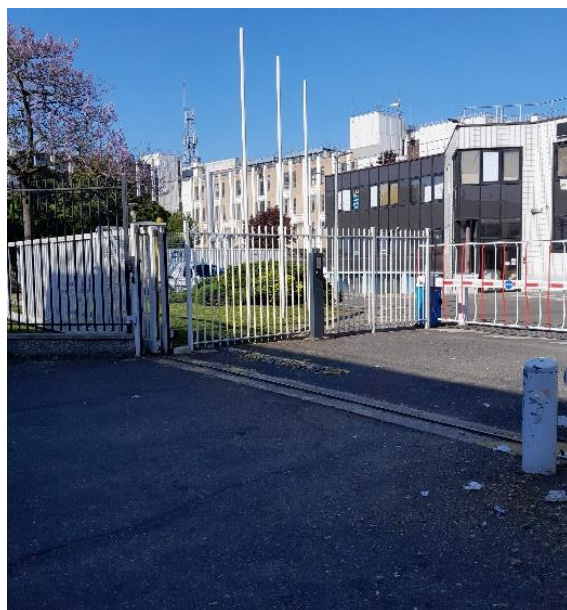
11 : Data Center DCC rue de la Motte
