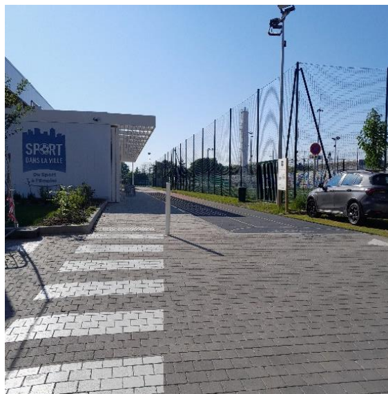
17 : stade Marcel Cerdan avenue Jean Jaurès
