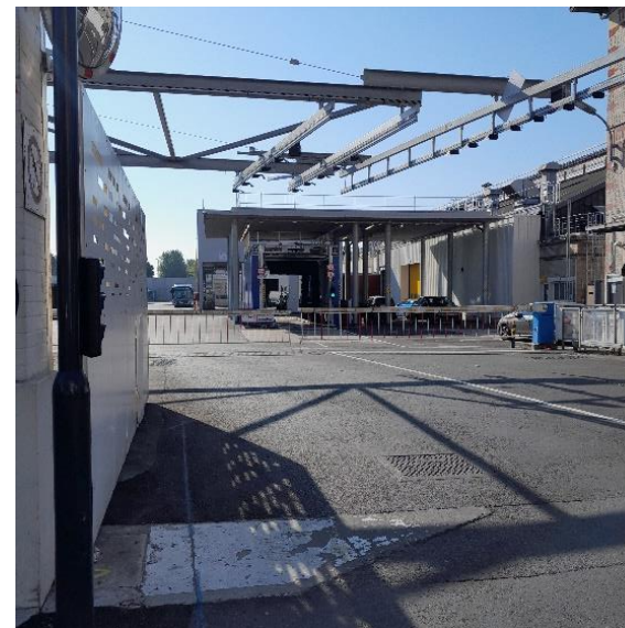
23 : ensemble de méthanisation des bus RATP avenue Jean Jaurès
