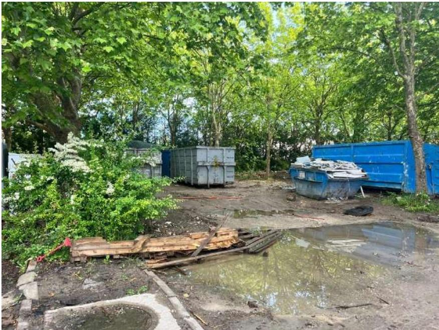
Figure 12 Zone décapée et remblayée de divers matériaux
