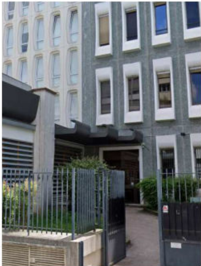
11 Auvent du rez-de-chaussée
