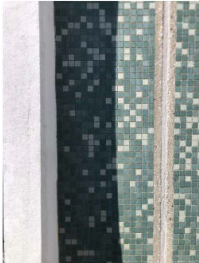
7 Détails des céramiques en façade
