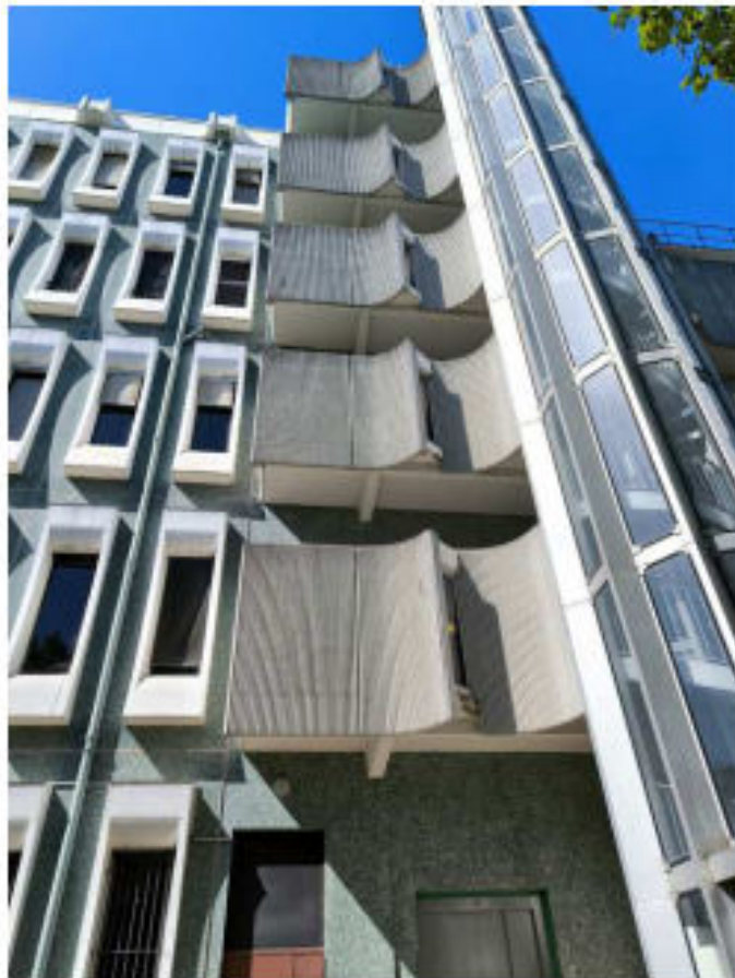
9 Façade Sud en béton armé
