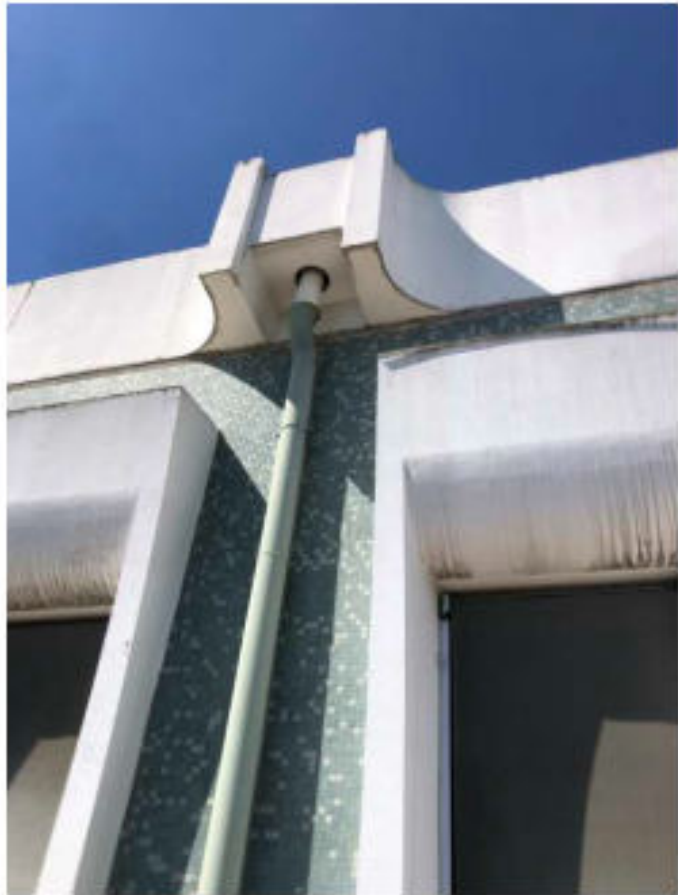
8 Détails des descentes d'eaux pluviales en toiture
