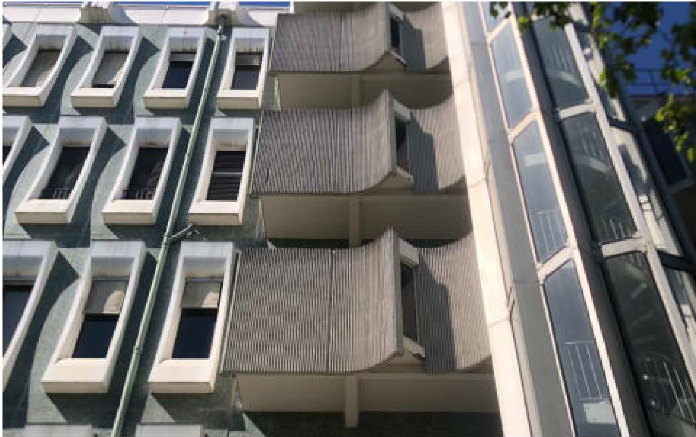
4 Vue du bâtiment F depuis le coeur d'îlot
