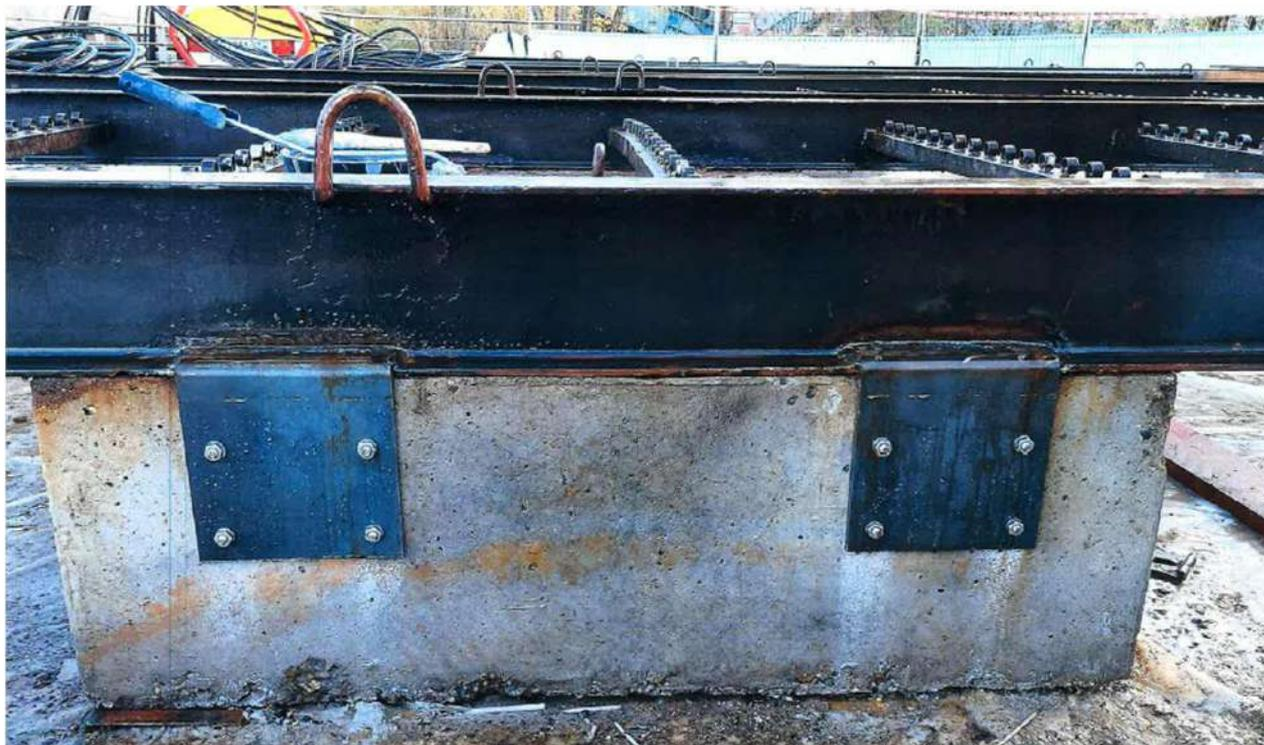
**Figure 3 : lest béton accroché au HEB du cadre d'insufflation d'oxygène**
