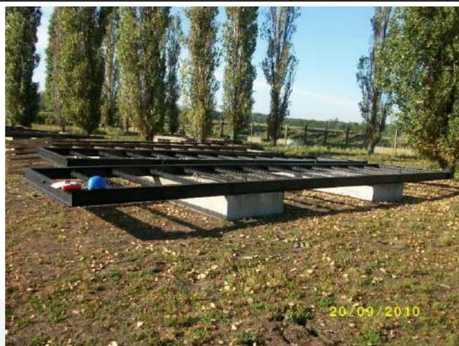
Figure 2 : Cadre à oxygène avec lestages béton
