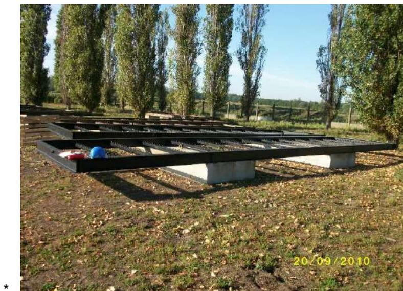
\* Figure 11 : Cadre à oxygène avec lestages béton
