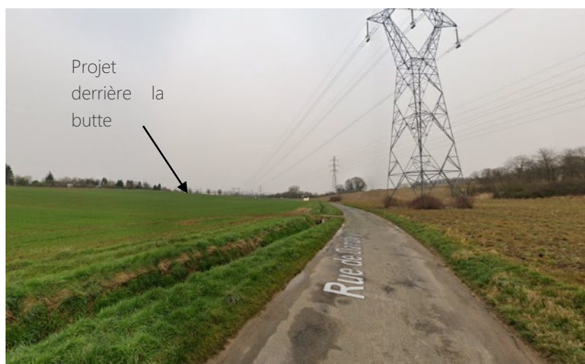
Prise de vue n°6 : Aucune visibilité sur la zone d'implantation. Localisation depuis rue à droite des pylônes RTE, photographie en direction de l'ouest. Aucune co-visibilité depuis ce point de vue au loin, seul le poste source déjà présent est visible. Prise en mars 2022, Google
