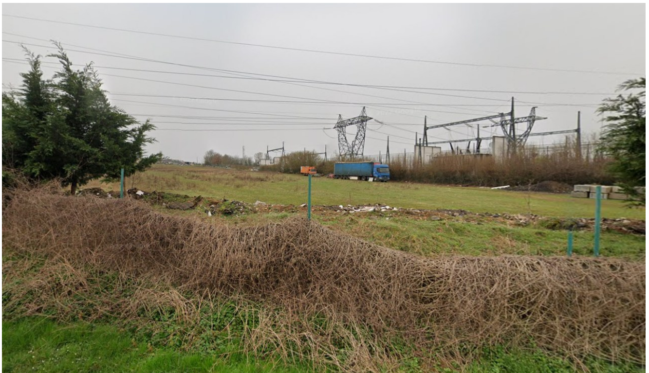
Prise de vue n°2 : Localisation depuis le chemin de Dampleger entre le carrefour avec la D405 et le chemin et l'entrée du poste source, photographie en direction du sud. Photographie proche prise en mars 2022, Google
