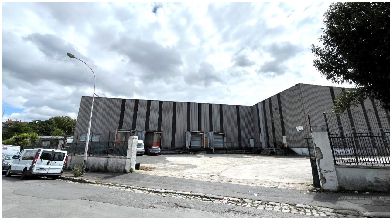
Photographie 4 : Vue sur les entrepôts situés au nord du site d'étude depuis la Rue de la Butte
