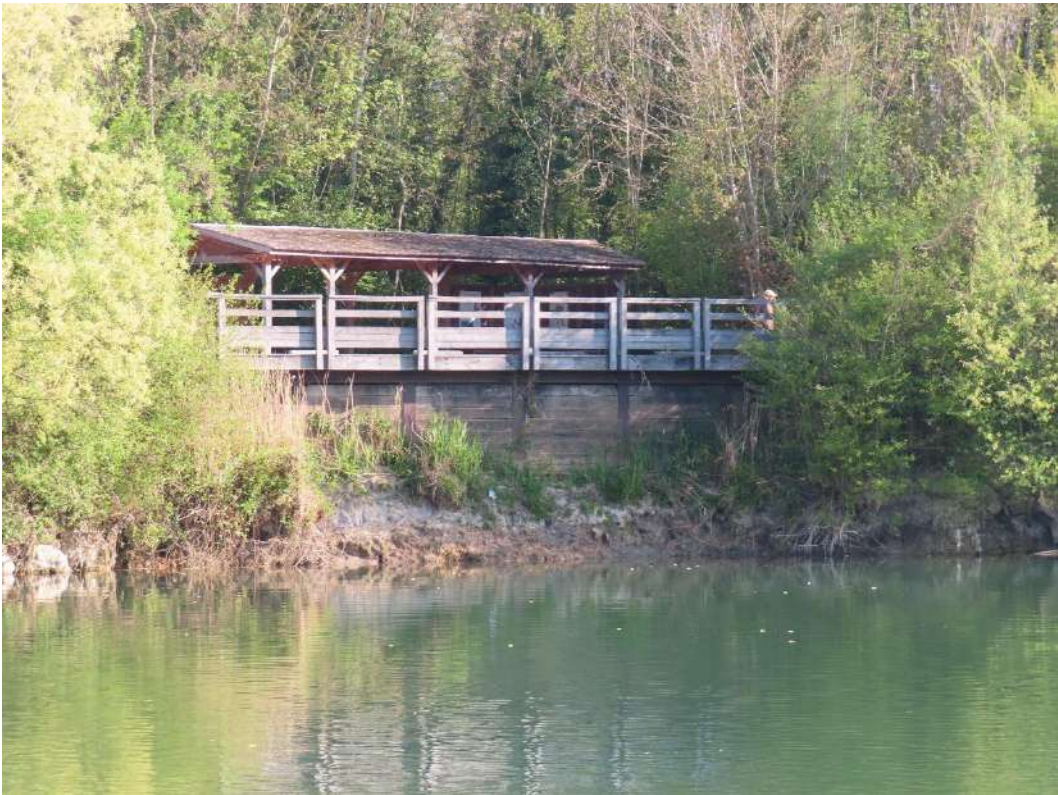
Photo 5 : Vue sur la terrasse en bois et préau rive Parc de la Haute-Île depuis la rive côté Noisy-le-Grand (Source : ADEV Environnement, avril 2025)
