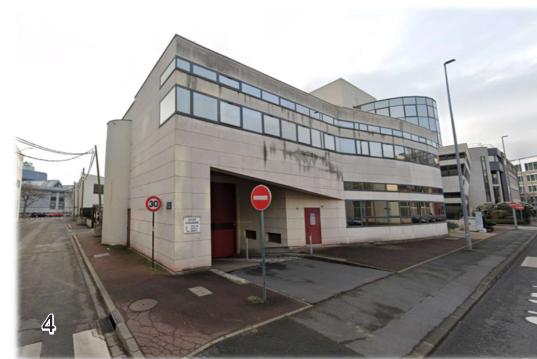
Vue depuis l'intersection de la rue Olof Palme avec l'allée Van Gogh
