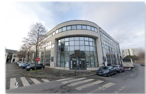
Vue sur un immeuble de bureaux en bordure de la rue Villeneuve
