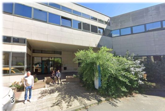
Vue sur l'entrée piétons secondaire depuis l'allée Jean Prouvé
