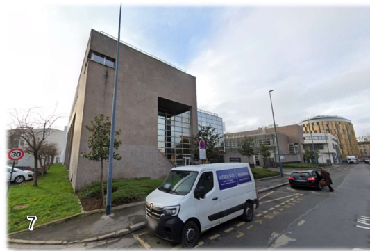
Vue sur un immeuble de bureaux en bordure de la rue Villeneuve
