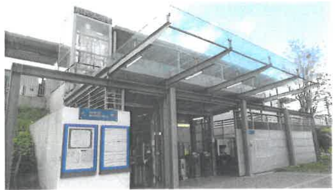
C - Vue de la gare d'Achères Ville (entrée est)
