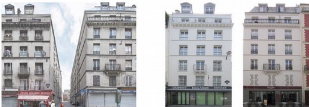
Réhabilitation de deux immeubles d'habitation de 1873 et 1880, Passage Goix (75019), Maîtrise d'ouvrage SIEMP, maîtrise d'œuvre F + L architectes
