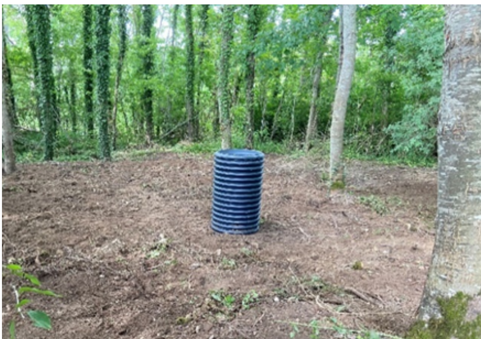
Fermeture d'un fontis avec mise en place d'un passage à chiroptères © PNR-VF
