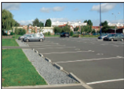
Tranchée drainante reprenant les eaux d'un parking (source Lille Métropole)
