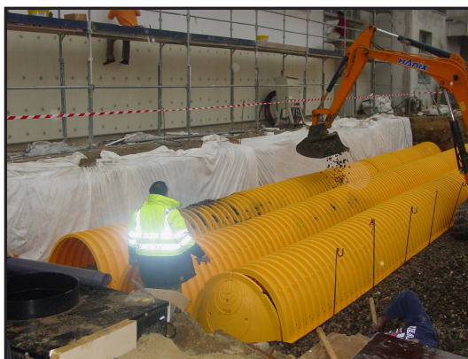
Structure réservoir mise en œuvre au collège Brossolette du Perreux-sur-Marne (photo DSEA)
