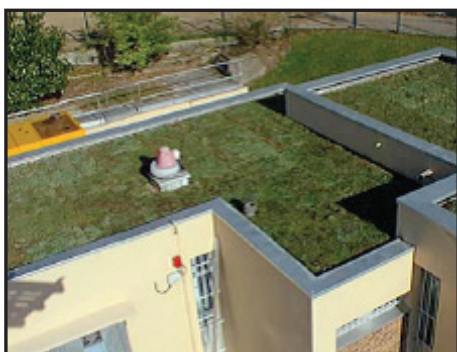
Une toiture stockante (source : Grand Lyon)
