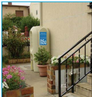
Exemple de cuve hors-sol Bac de récupération des eaux pluviales à Chevilly-Larue (photo Cg94)
