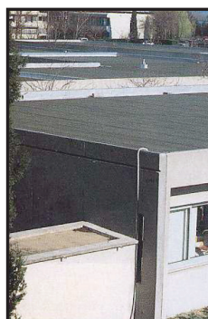
Toiture-terrasse (Source : CERTU)
