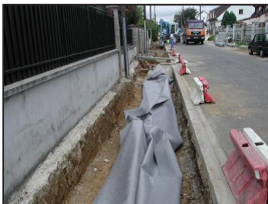
Mise en place d'une structure drainante à Ozoir la Ferrière en Seine-et-Marne (source : AESN)
