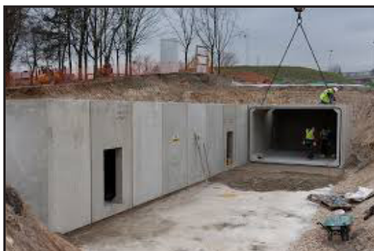
Structure réservoir mise en œuvre au collège Brossolette du Perreux-sur-Marne (photo DSEA)
