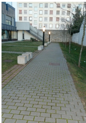
Voie en pavés non jointifs à Limeil-Brévannes dans le Val-de-Marne (Photo DSEA)
