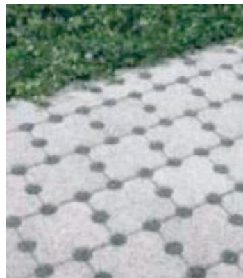
Exemple de pavés perforés (Source : Grand Lyon)
