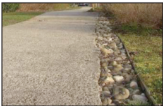
Tranchée drainante le long d'un espace piétonnier (Source : Grand Lyon)
