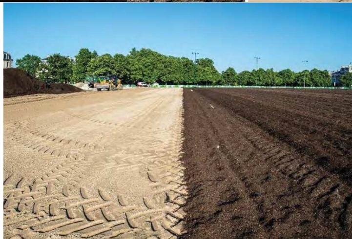
**Figure 4 : Epandage de compost sur terre inerte – chargeuse et tracteur avec remorque d'épandage**
