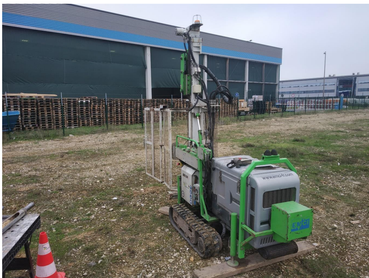
Photographie n°3 (vue sur site) - Novembre 2022, emplacement de la future cellule 6
