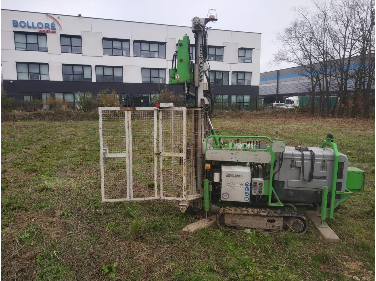
Photographie n°4 (vue sur site) - Novembre 2022, emplacement du futur parking silo
