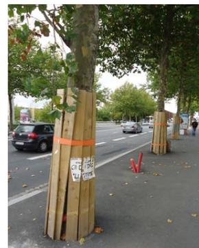
Exemple d'une protection insuffisante des arbres en phase chantier.
