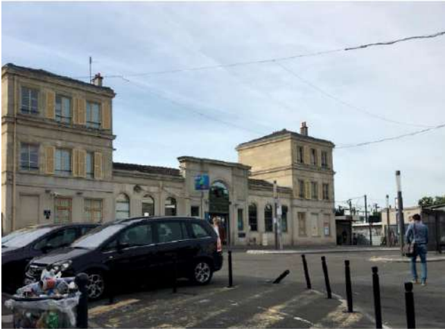
Figure 6 : Vue du parvis de la gare du bâtiment voyageurs
