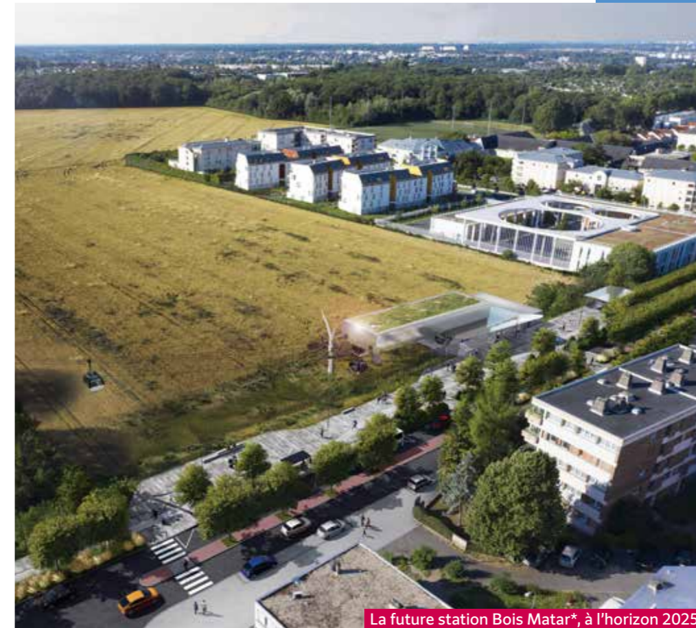
Emplacement de la station, février 2023
