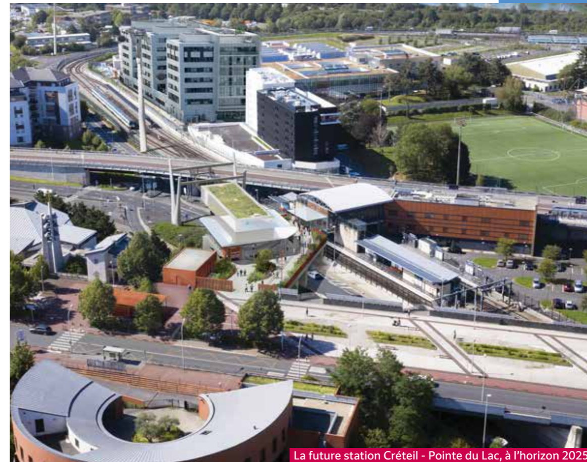
Emplacement de la station, février 2023
