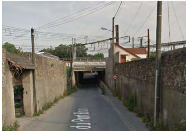
Figure 179 : Vigneux-sur-Seine - Passage routier sous la voie ferrée
