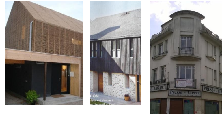
La présence d'éléments architectoniques en saillie ou de balcon rend l'isolation thermique par l'extérieur inopérante.
