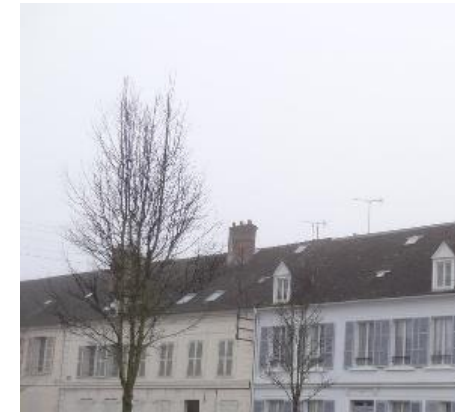
Une surélévation d'une des toitures même de quelques dizaines de centimètres romprait l'uniformité de la ligne de faîtage et créerait des lignes de raccordement toujours fragiles.
