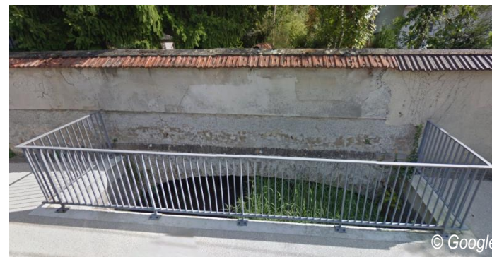
Passage du ru du Bras Saint-Père sous la rue de l'Imprimerie
