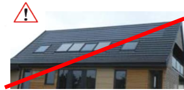
A éviter : la dispersion d'éléments de hauteur différente sur la toiture
