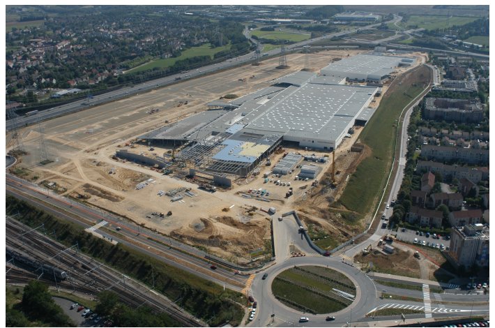
Construction du centre commercial « Bay 2 » à Torcy (68 000 m 2 ) © Gobry – DRIEA – 2002
