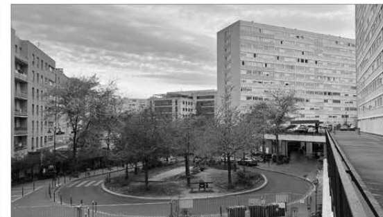
Vue de la rue Favardin et des entrées depuis le parking de la cité Etat existant, 2022
