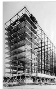
Pose des planches préfabriquées sur la grille d'acier Photographie de chantier, 1960
