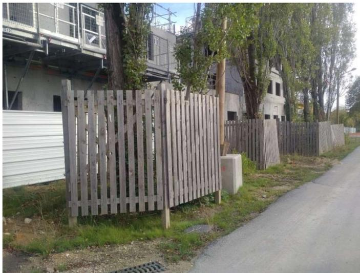
Figure 126. Protection des arbres individuellement
