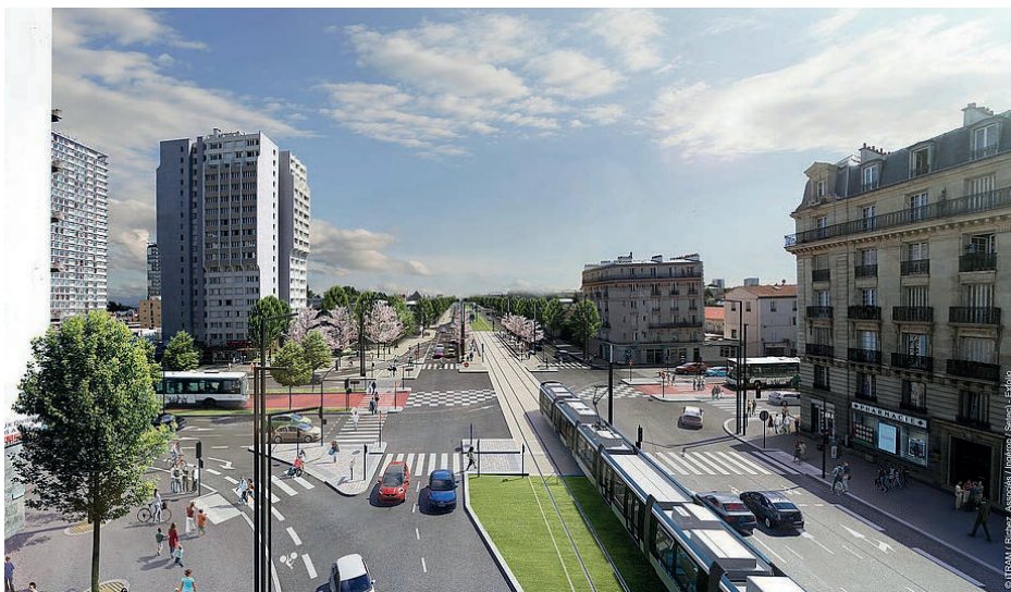
Une vue à hauteur de Choisy-le-Roi, avec l'installation du tramway T9
