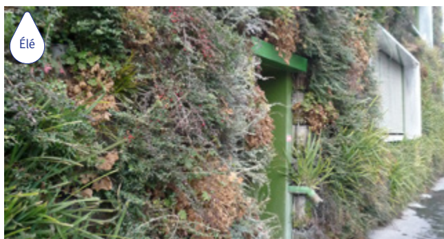
MURS VÉGÉTALISÉS ZAC BATIGNOLLES.
