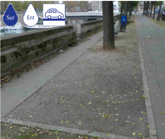
BD BOURDON : REVÊTEMENT PERMÉABLE ENTRE LES ARBRES. Source : © APUR
