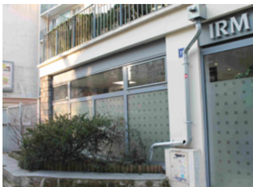
ALIMENTATION D'UNE JARDINIÈRE EN PIED DE FAÇADE PAR RACCORDEMENT DIRECT DE LA GOUTTIÈRE.
