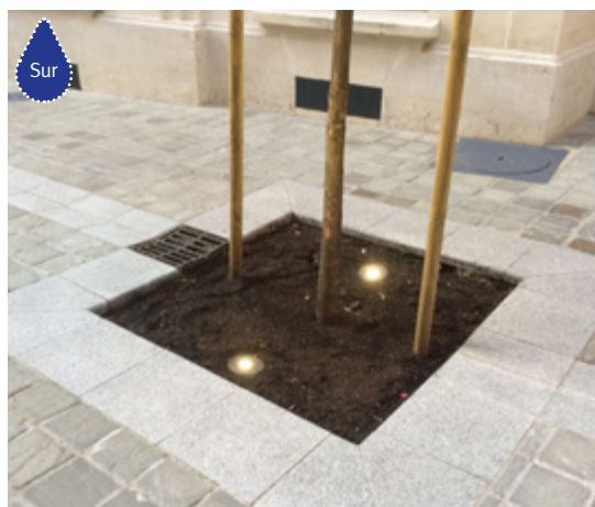
FOSSÉ D'ARBRE DÉCAISSÉE - NEUILLY (92).
