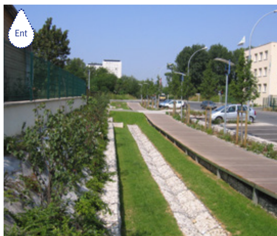
CLICHY-SOUS-BOIS (93) : PARC D'ACTIVITÉ - TRANCHÉE DRAINANTE POUR LE RESSUYAGE DE LA NOUE.
