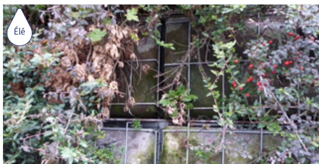
MURS VÉGÉTALISÉS ZAC BATIGNOLLES.
