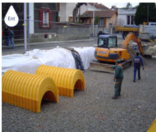
VAL DE MARNE : BASSIN EN STRUCTURES ALVÉOLAIRES.
