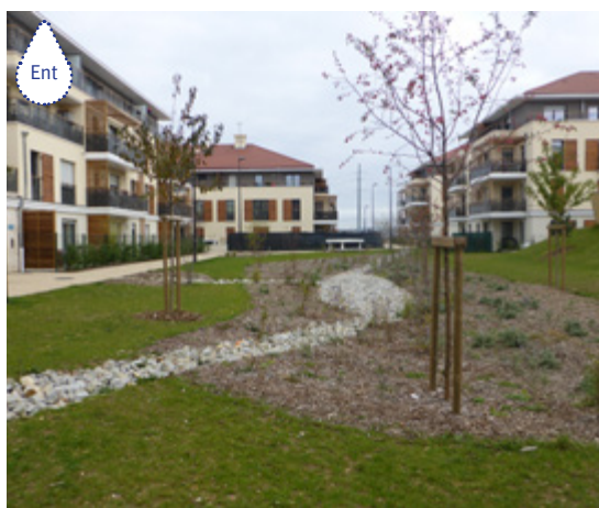
MAGNANVILLE (78) : RÉSIDENCE DES MANGAZONS : TRANCHÉE DRAINANTE CONNECTÉE À UN SYSTÈME DE PUITS D'INFILTRATION - STOCKAGE PAYSAGER.
