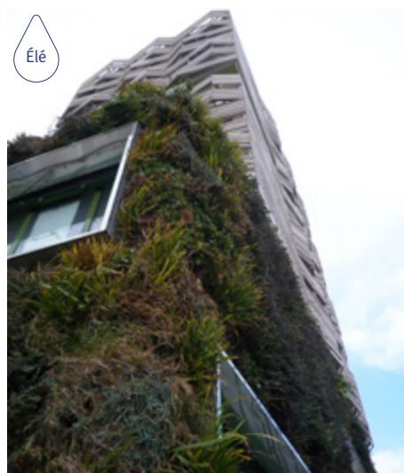
MURS VÉGÉTALISÉS ZAC BATIGNOLLES.
