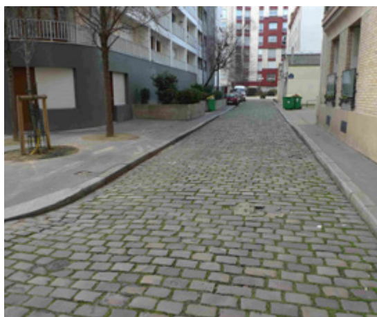
PASSAGE MONTBRUN : PAVÉS À JOINTS ENGAZONNÉS.
