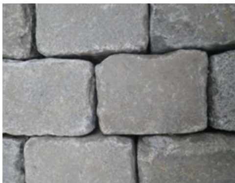
PAVAGE CORRECTEMENT POSÉ : LES PAVÉS SE TOUCHENT.
