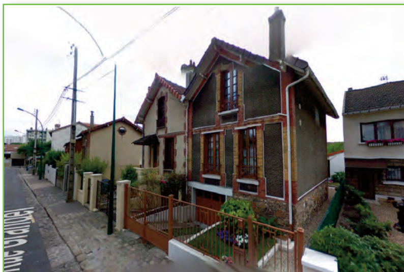
État existant des pavillons voisins (Source Google 2016)
