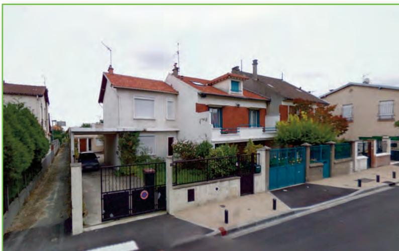
État du pavillon avant la transformation (Source Google 2016)
