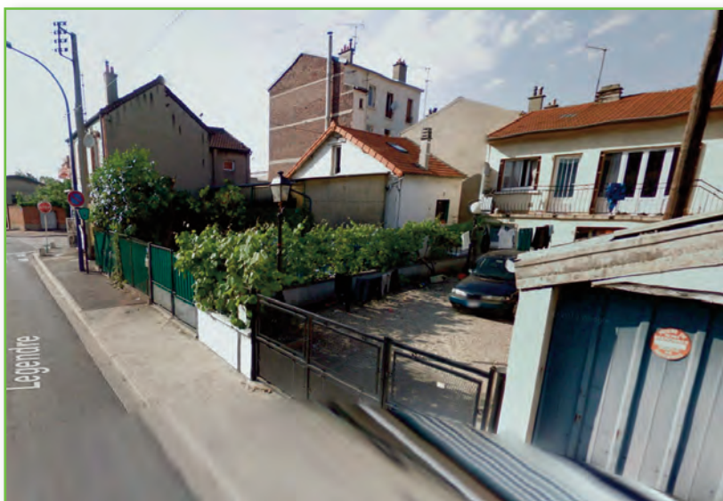
État du pavillon après extension (Source Google 2016)
