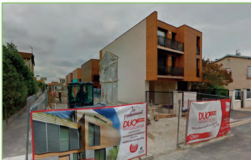
État du pavillon pendant la transformation (Source Google 2016)
