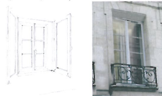
La technique de la double fenêtre est courante dans les régions froides, notamment en montagne
