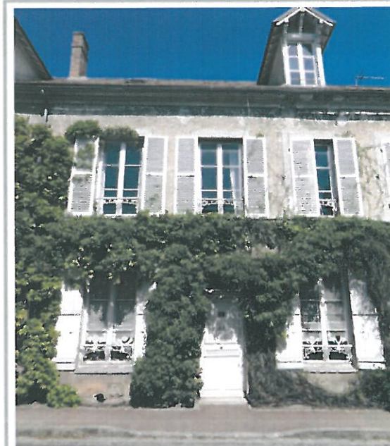
Les menuiseries de fenêtre et les volets pleins en rez de chaussée et les volets persiennés à l'étage composent fortement le dessin de la façade.
