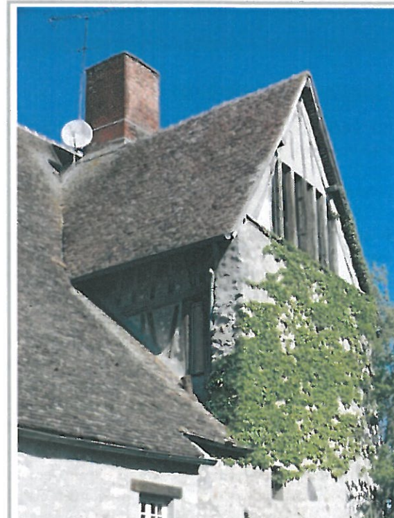
Une surélévation de la toiture même de quelques dizaines de centimètres n'est pas possible sur ce type de construction.
