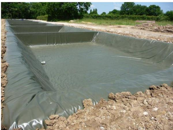
Bassin de rétention avec étanchéité par géomembrane
