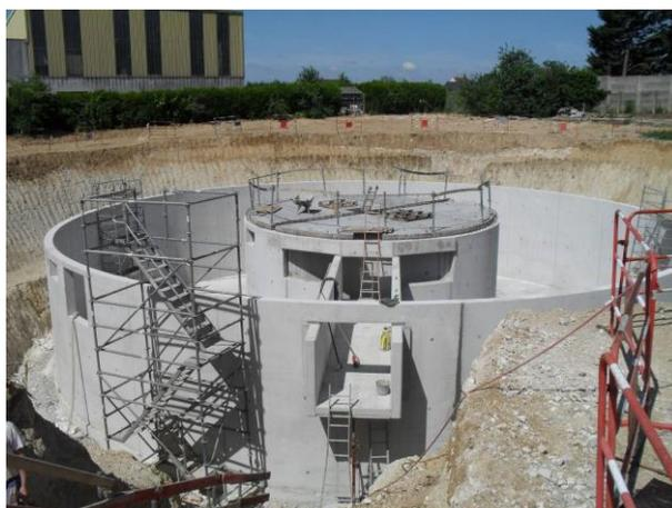
Bassin de rétention en béton armé
