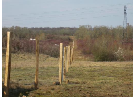
Cloture après travaux (mars 2012 © AEV)
