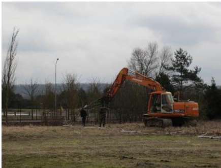
Installation des piquets de clôture à la grue hydraulique (février 2012 © AEV)
