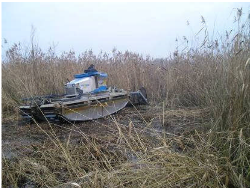
Pendant les travaux automne 2010
