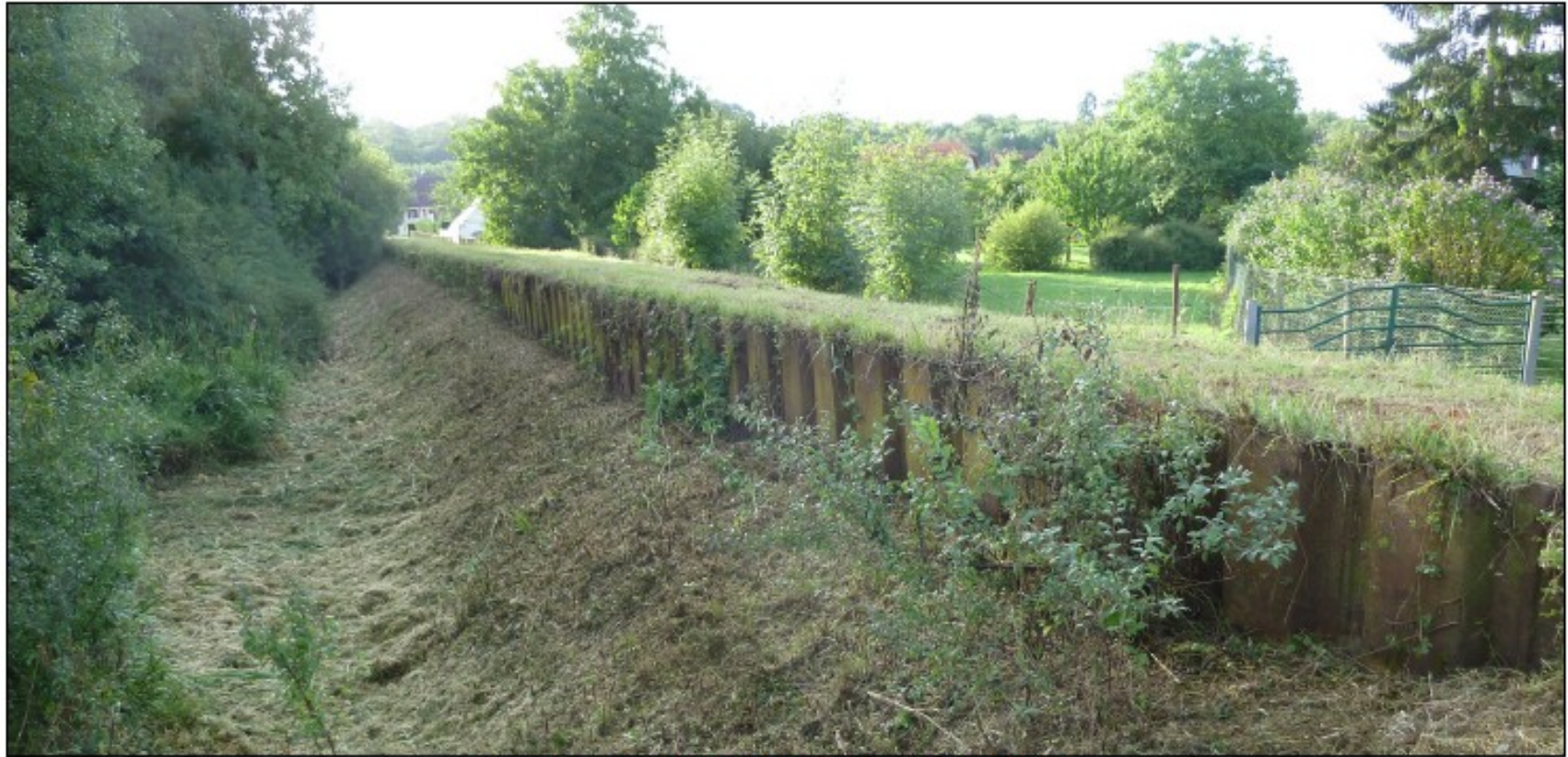
Vue générale de la digue de Marizelle
